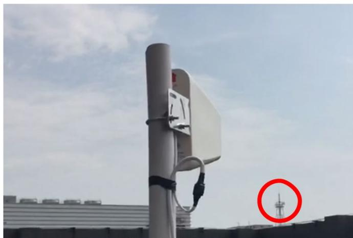
3) Подсоедините кабель к антенне и загерметизируйте соединение водонепроницаемой пленкой. Длина кабеля не должна превышать 20 м.
